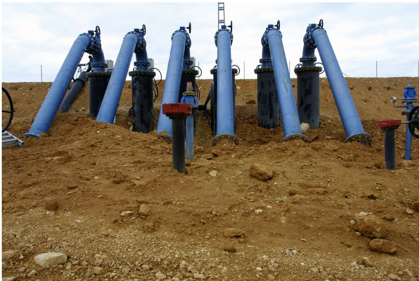
Tomas de la sustitución de bombeos - Foto: A.P.
