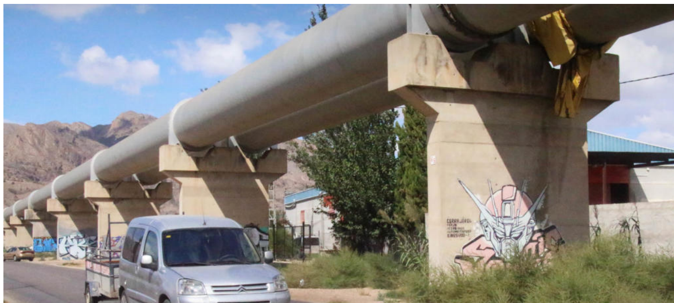
Un coche pasa junto a la infraestructura del Tajo-Segura en la Vega Baja. tony sevilla
