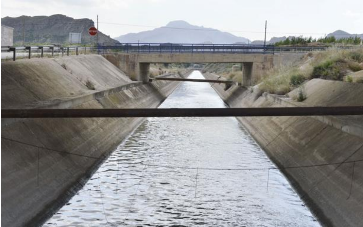
Canal del Postrasvase a su paso por Campotéjar, en Molina de Segura. / GUILLERMO CARRIÓN / AGM
