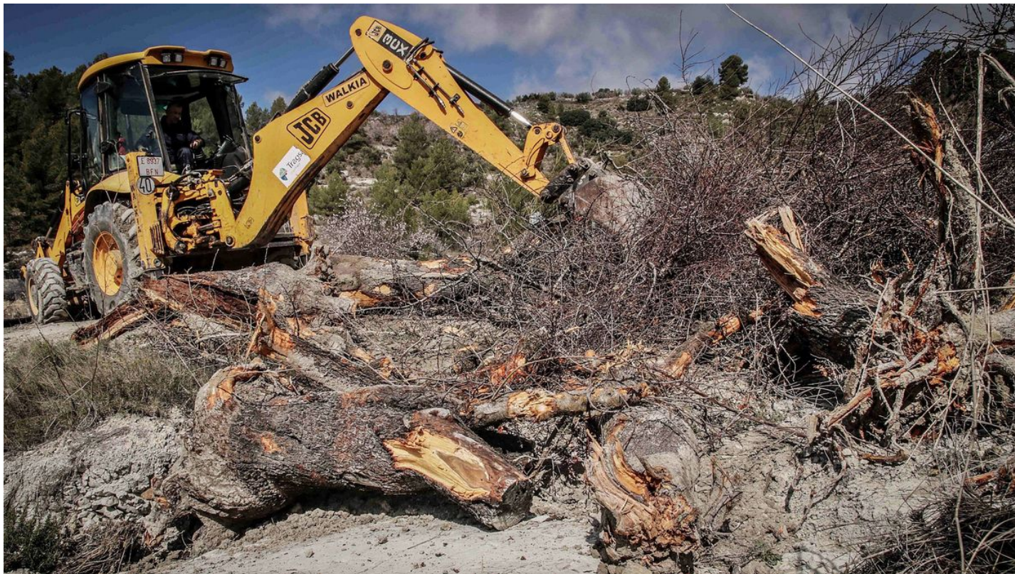
Una excavadora arrancando almendros en el pueblo de Balones. JUANI RUZ
