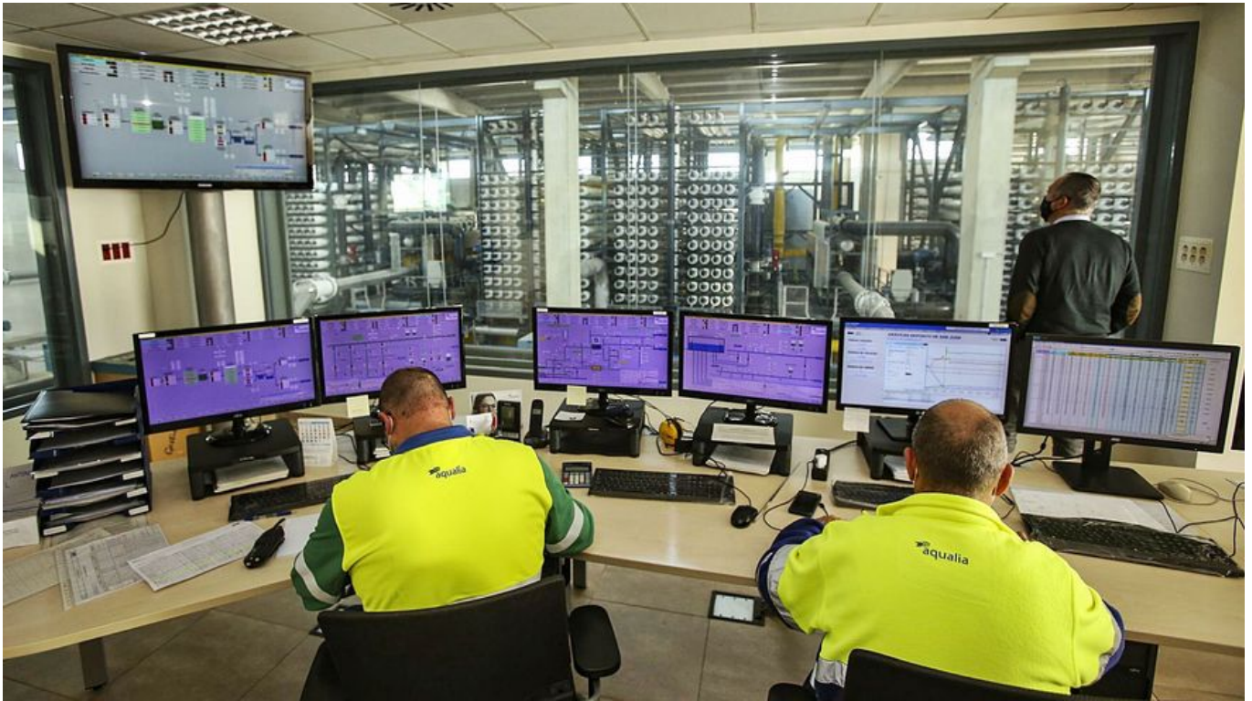
Dos técnicos supervisan telemáticamente el proceso de captación y depuración del agua del mar desde el puesto de control. MANUEL R. SALA
