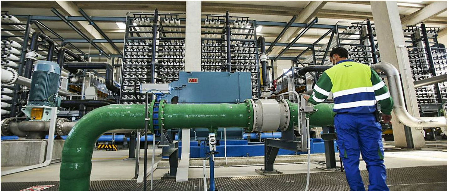
Un operario revisa una tubería en el interior de la planta. MANUEL R. SALA
