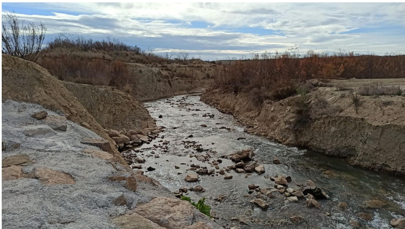
Cauce horadado por la toma de entrega de agua del trasvase al embalse de la Pedrera PAMIES
