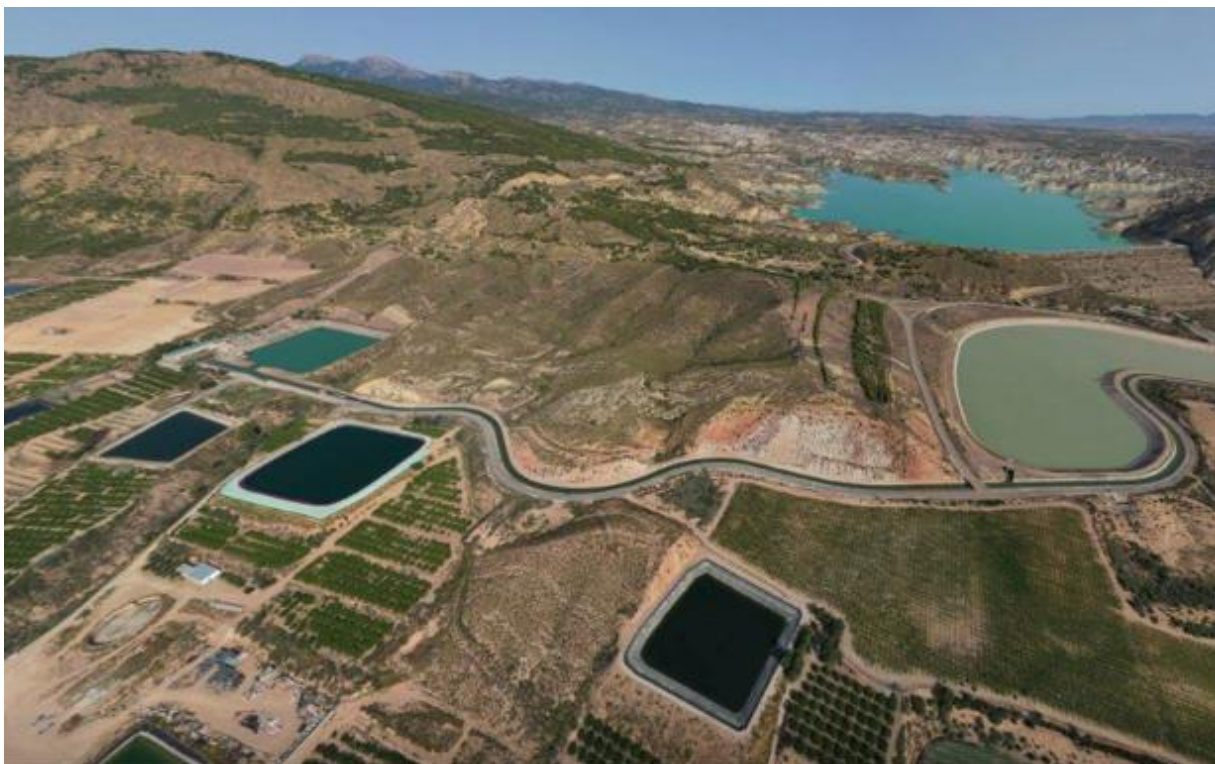
Vista aérea del embalse de Algeciras, en Librilla, que sirve de regulación para el canal del Postrasvase de la margen derecha. / CHS
