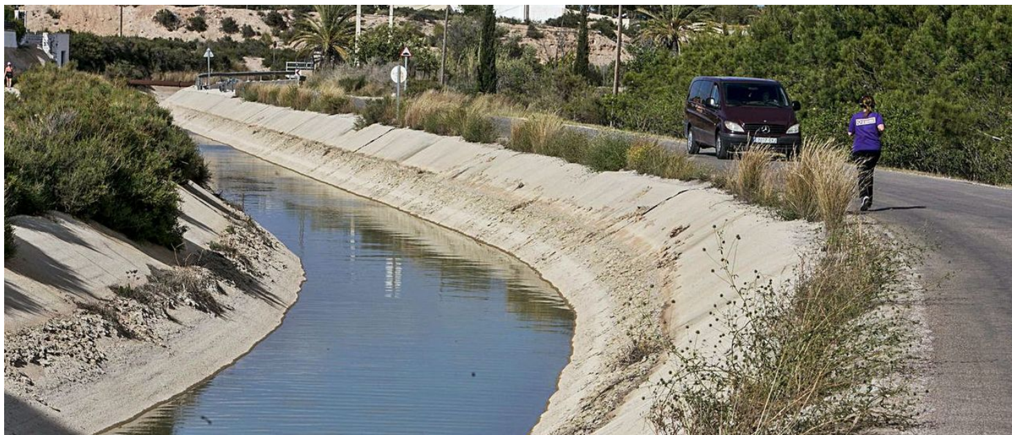
Canal de reparto del agua del Tajo-Segura en el Campo de Elche. | ANTONIO AMORÓS
