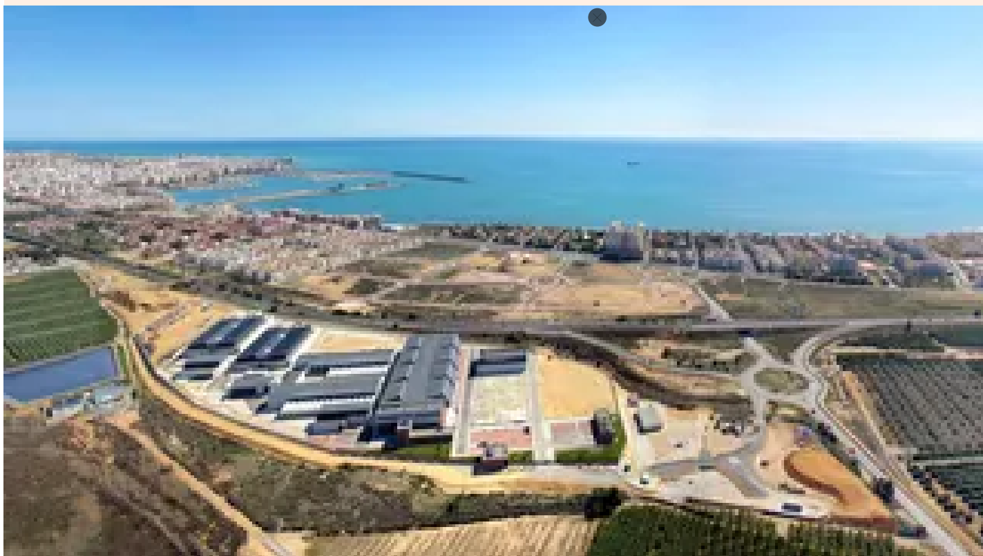
Desalinizadora de Torrevieja, gestionada por Acuamed.
