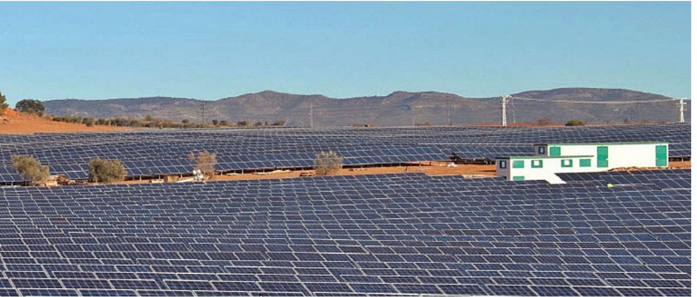
Planta solar de Edisun Power en Requena. | LEVANTE-EMV
