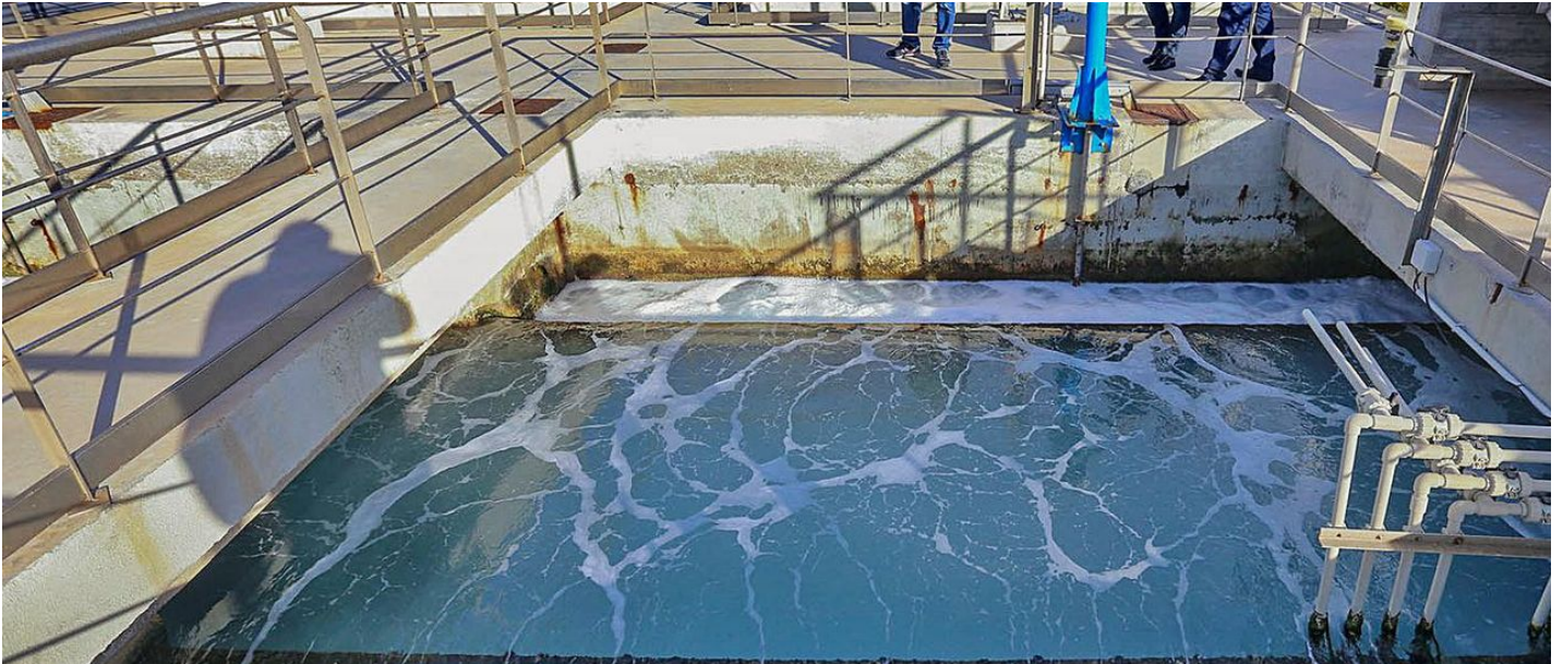
Imagen de la planta desalinizadora de Torrevieja. | TONY SEVILLA
