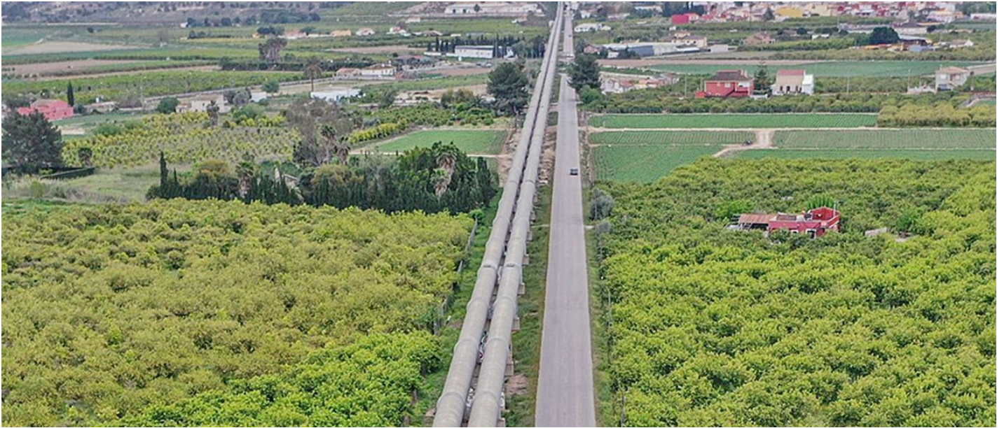
Infraestructura del trasvase Tajo-Segura en la comarca de la Vega Baja. | TONY SEVILLA
