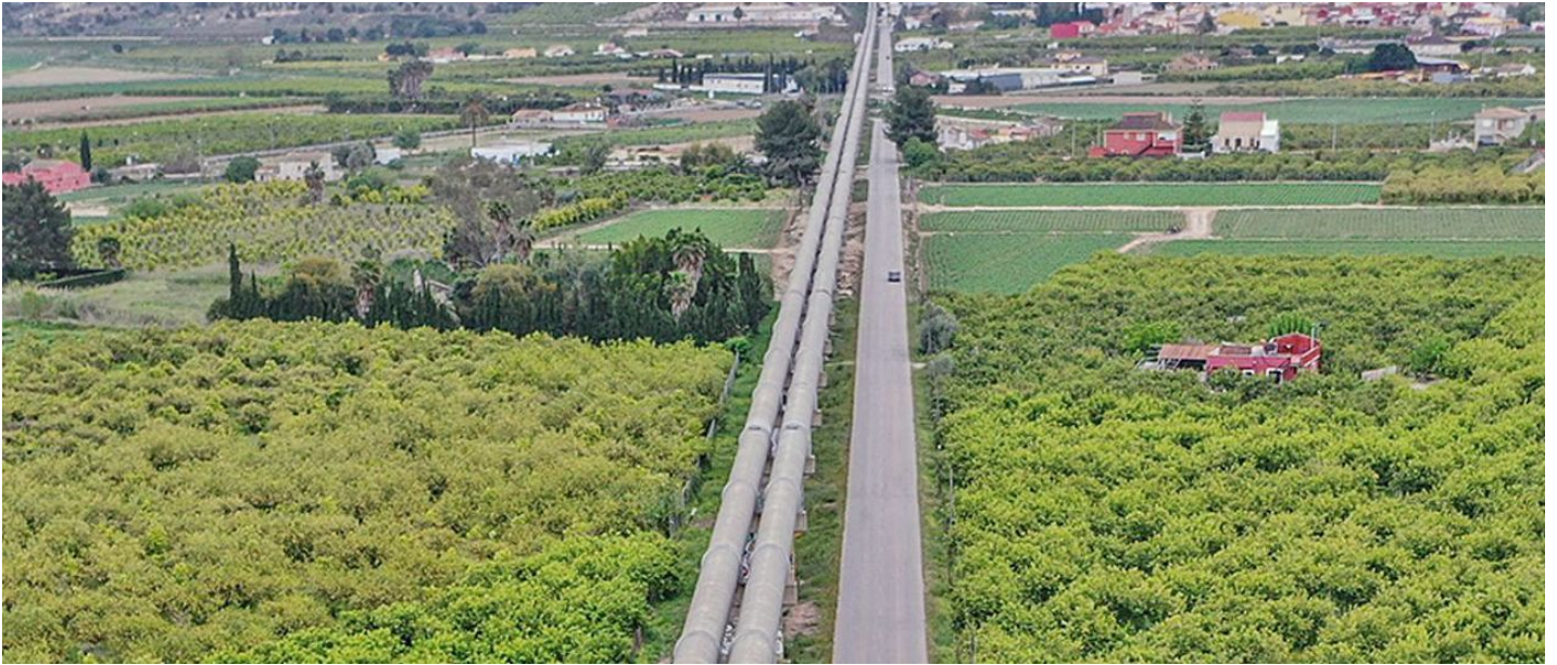
Tuberías del Tajo-Segura para el reparto del agua por la Vega Baja. | TONY SEVILLA
