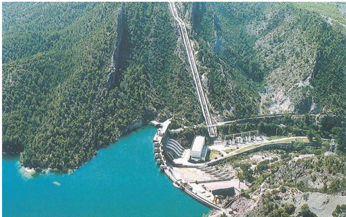
Nacimiento del Trasvase en la presa de Bolarque, Cuenca. / LV
