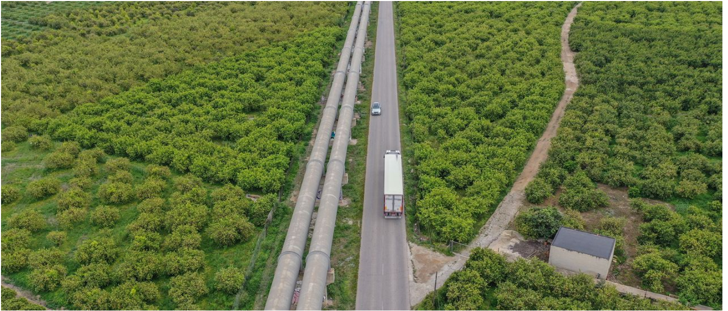
Un camión cargado con frutas y hortalizas circula junto a las tuberías del trasvase. TONY SEVILLA
