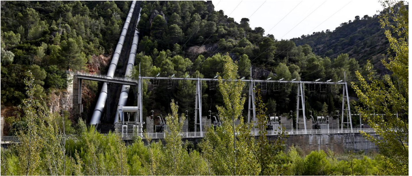
Embalse de Bolarque, regulador del agua del trasvase antes de partir hacia Alicante PILAR CORTÉS
