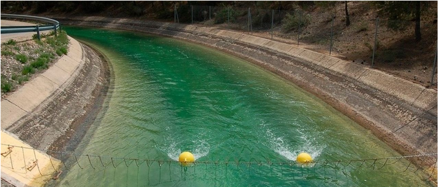
Canalización del trasvase Tajo-Segura
