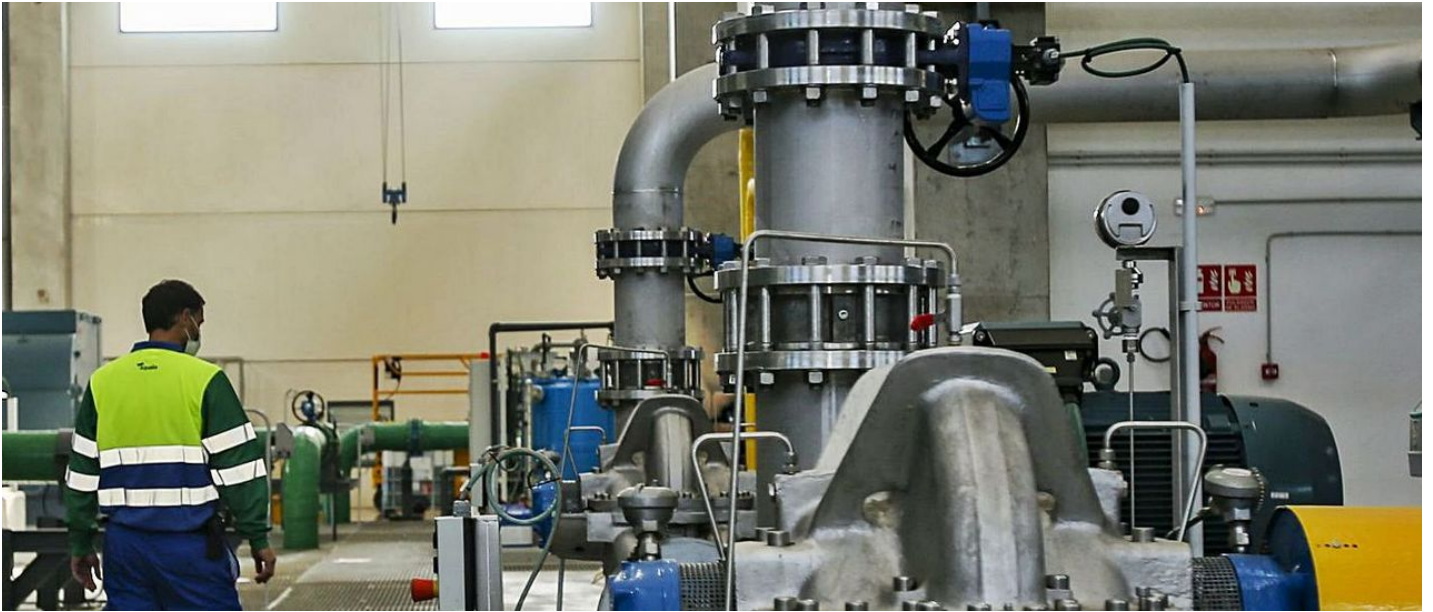
La desaladora de Mutxamel, cuya captación y vertido de aguas realiza en El Campello. | MANUEL R. SALA
