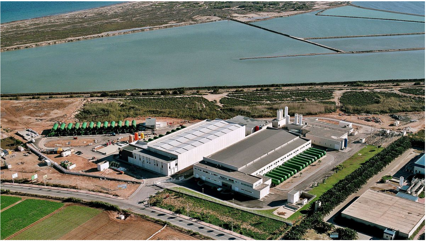
Vista aérea de las plantas desaladoras de la Mancomunidad de Canales del Taibilla en San Pedro del Pinatar. | M.C.T.
