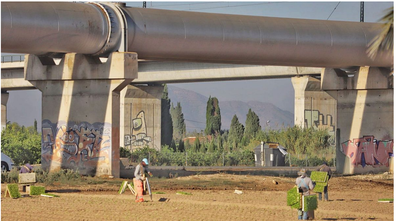
Jornaleros del campo trabajando ayer junto a las tuberías del trasvase Tajo-Segura en Orihuela. | TONY SEVILLA
