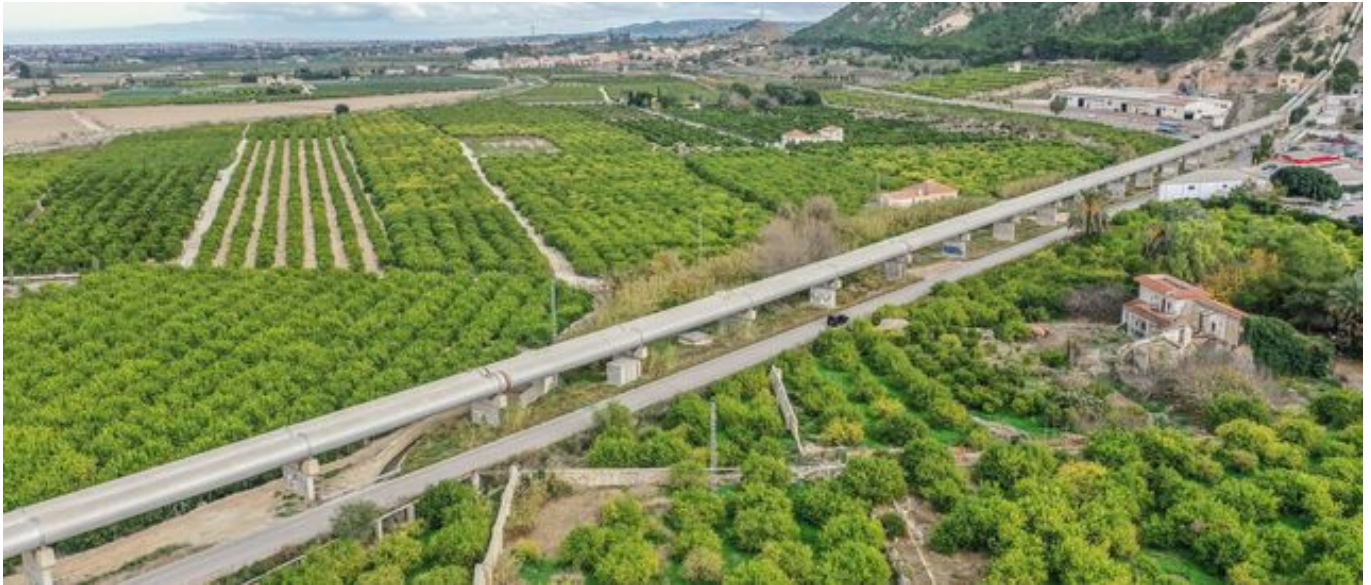
Imagen aérea de las tuberías del trasvase a su paso por la Vega Baja
