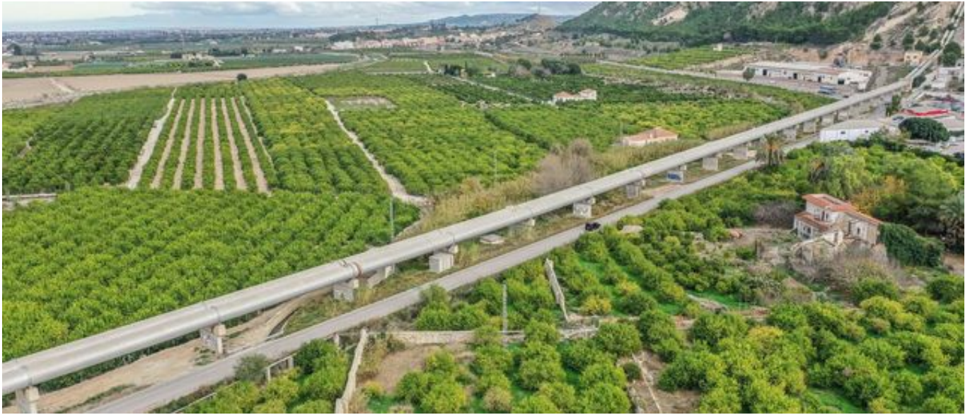
Imagen aérea de las tuberías del trasvase en la Vega Baja
