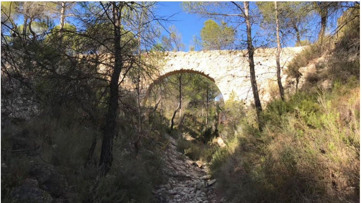
Un acueducto abandonado en Salinas
