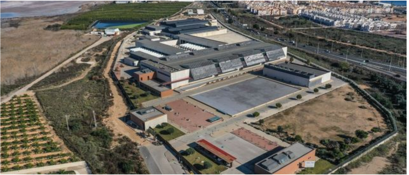
Vista aérea de la desaladora de Torrevieja, donde el Ministerio para la Transición Ecológica quiere instalar energía fotovoltaica. | TONY SEVILLA
