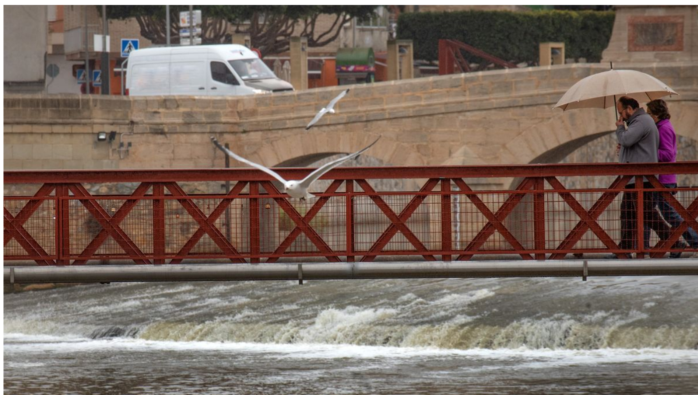
Imagen de la crecida del Segura a su paso por Orihuela / TONY SEVILLA
