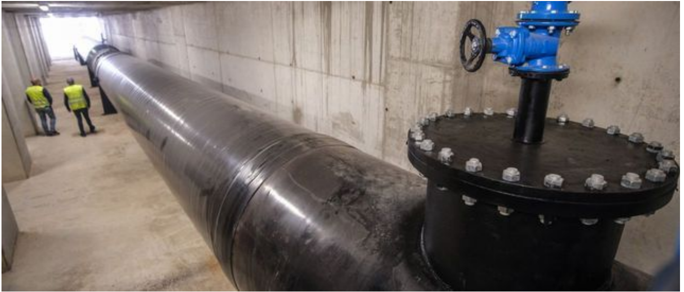
Infraestructura del embalse de la Cuesta en Villena AXEL ALVAREZ
