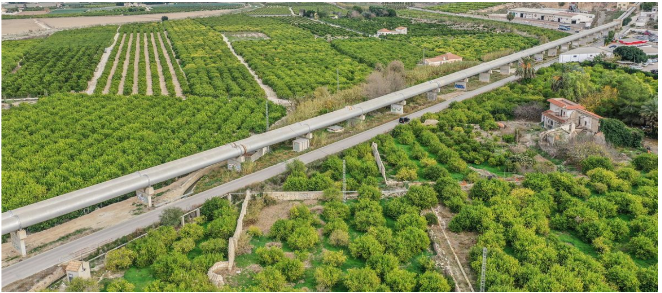
Vista aérea de la infraestructura del trasvase a su paso por Orihuela TONY SEVILLA
