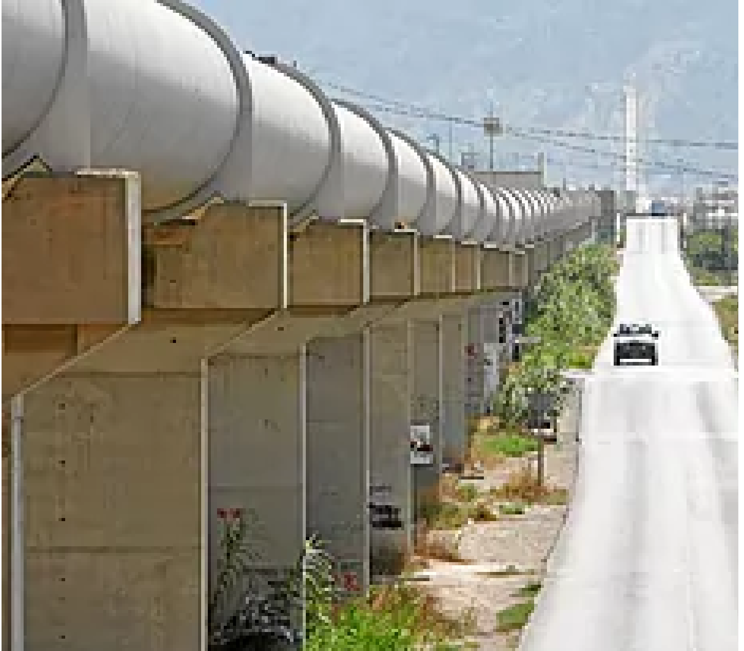
Infraestructura del acueducto Tajo-Segura a su
