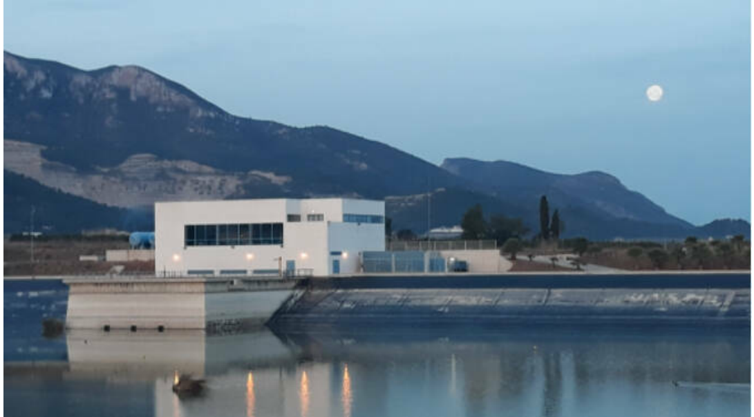
Estación de bombeo y balsa Panser, en Llaurí. Foto: CHJ
