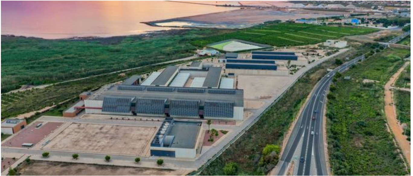
Planta desalinizadora de Torrevieja, junto a la laguna rosa , el casco urbano y las salinas TONY SEVILLA
