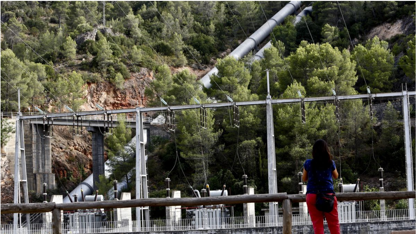
Embalse regulador de Bolarque, desde donde parte el agua para Alicante PILAR CORTÉS
