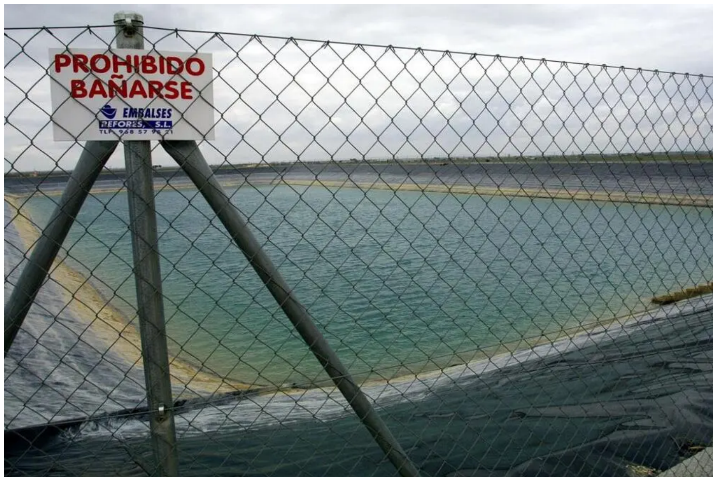
Balsa de regulación de la sustitución de bombeos. - Foto: A.P.
