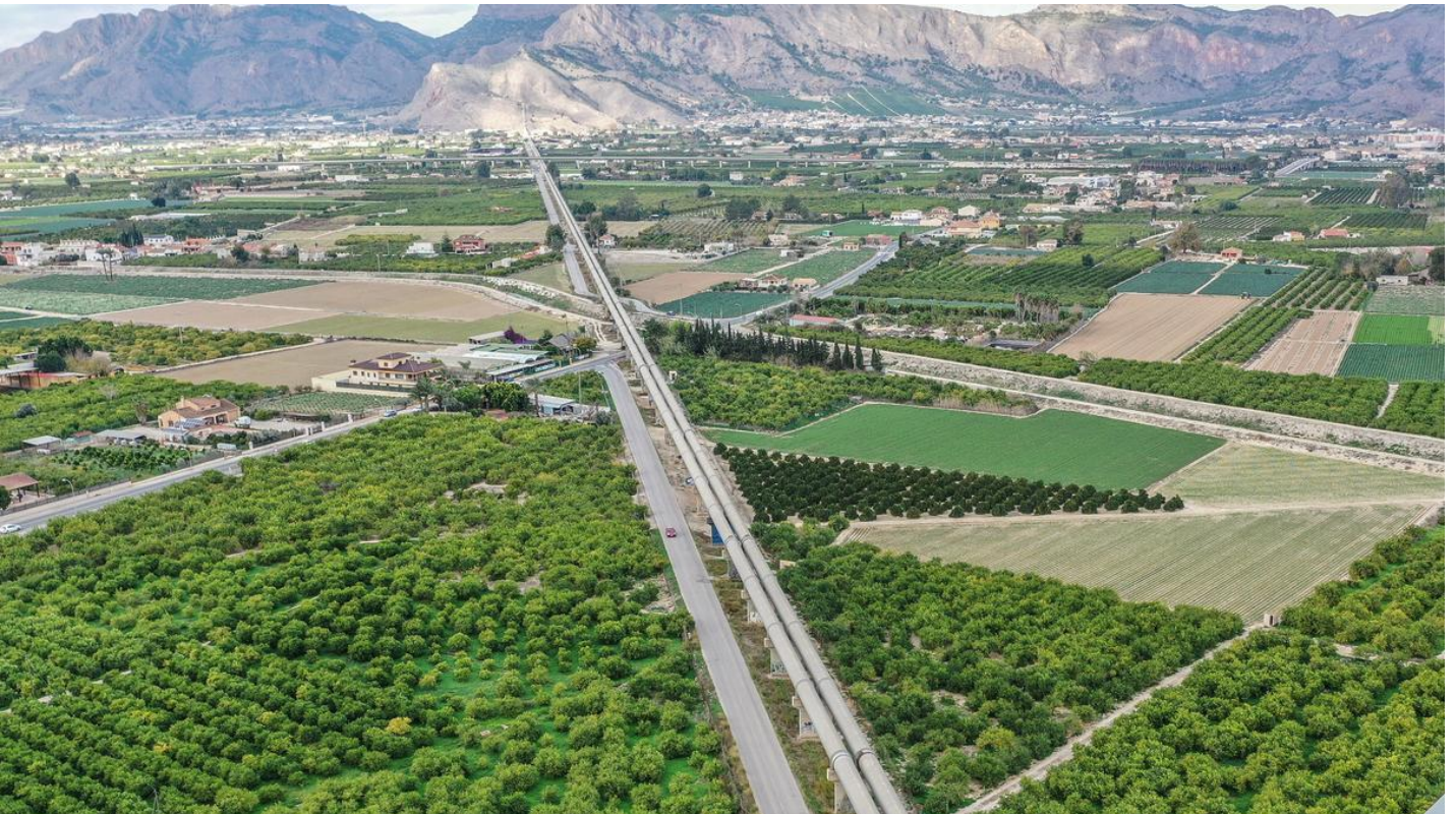
Vista aérea de los tubos del trasvase Tajo-Segura pasando por la huerta de Orihuela TONY SEVILLA
