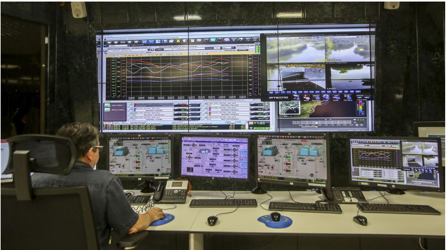
Un técnico controla la distribución del agua en Alicante. PILAR CORTÉS
