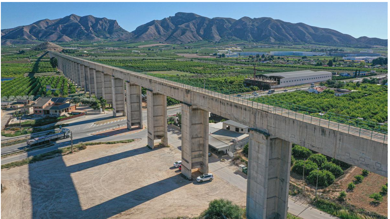
El trasvase está cerrado para reparar unas fugas hasta la próxima primavera TONY SEVILLA
