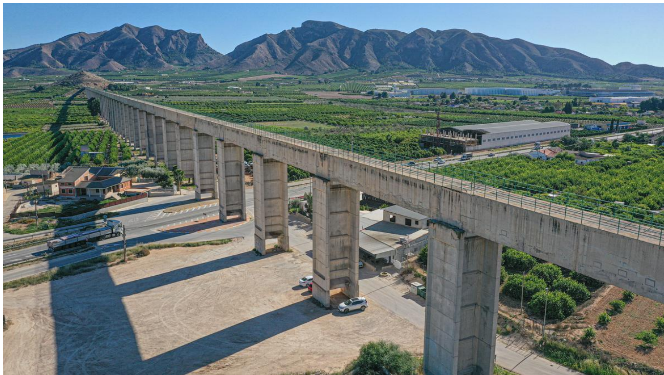
Obras en el acueducto del postrasvase entre Santomera y Orihuela TONY SEVILLA
