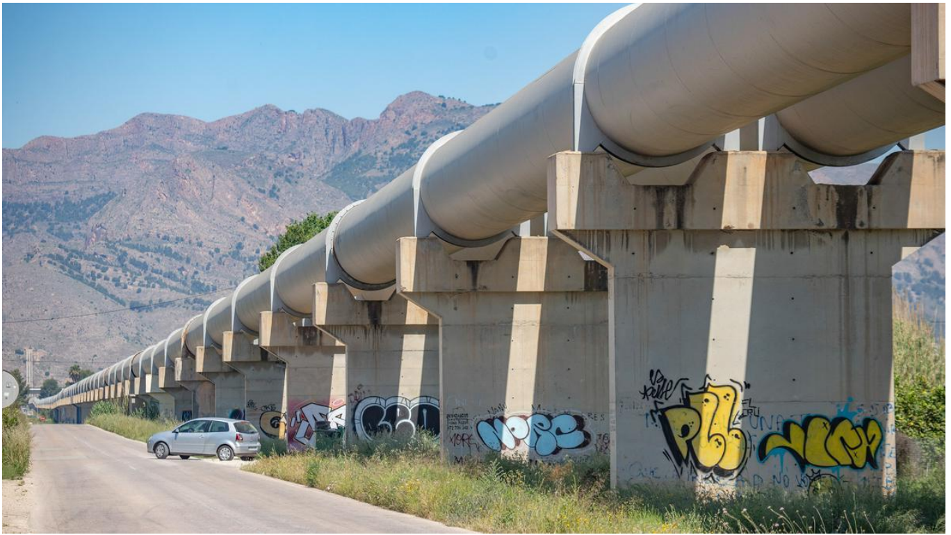
Los tubos del trasvase aportan caudales al embalse de regulación de La Pedrera TONY SEVILLA
