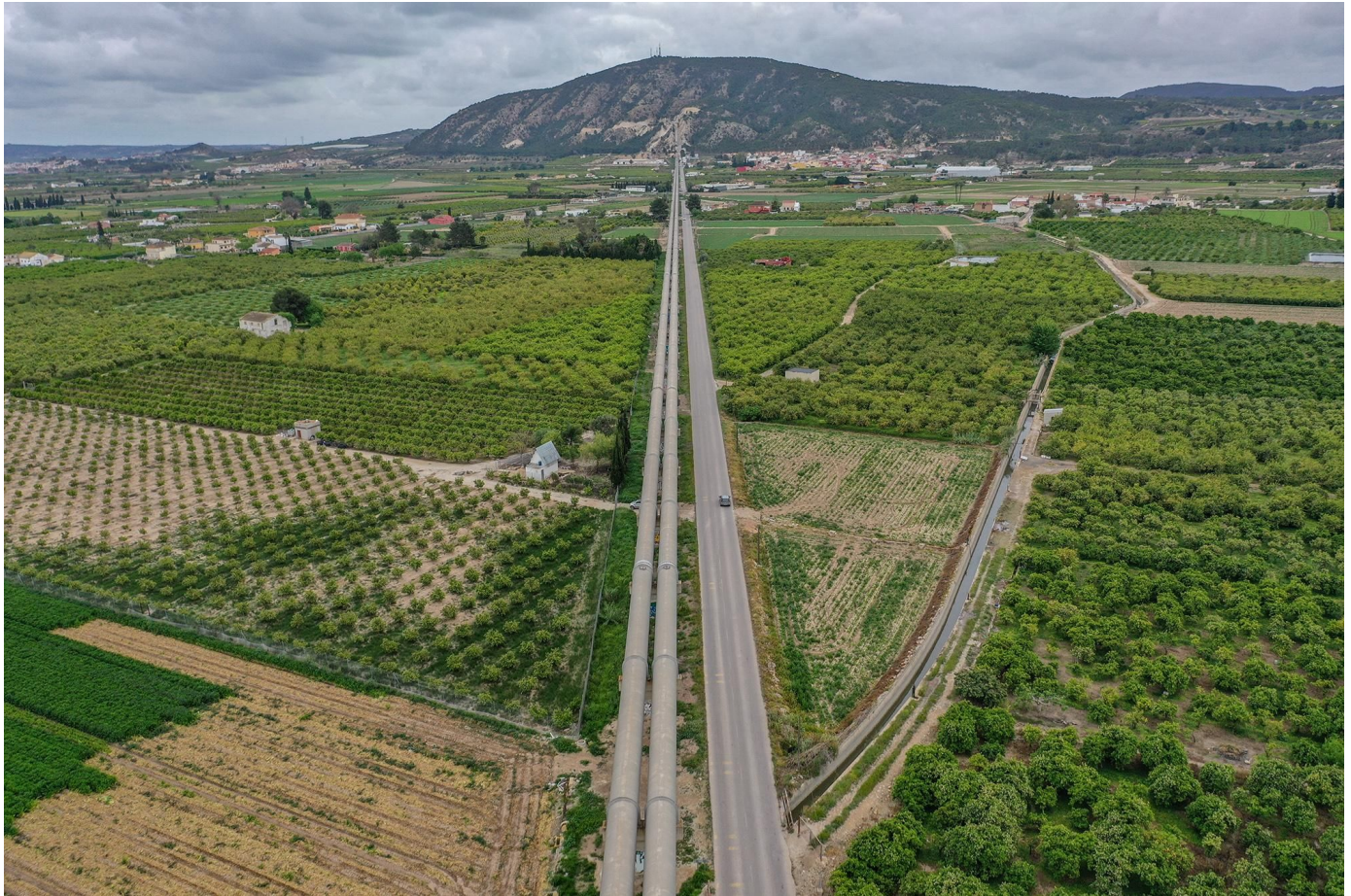
Vista aérea de las conducciones del trasvase Tajo-Segura a su paso por el término municipal de Orihuela. TONY SEVILLA
