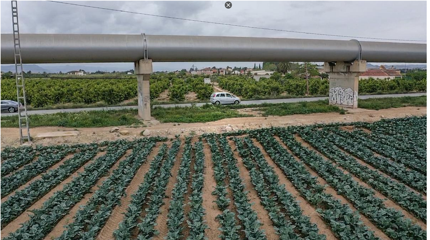
Las conducciones del trasvase Tajo-Segura a su paso por el término municipal de Orihuela. TONY SEVILLA
