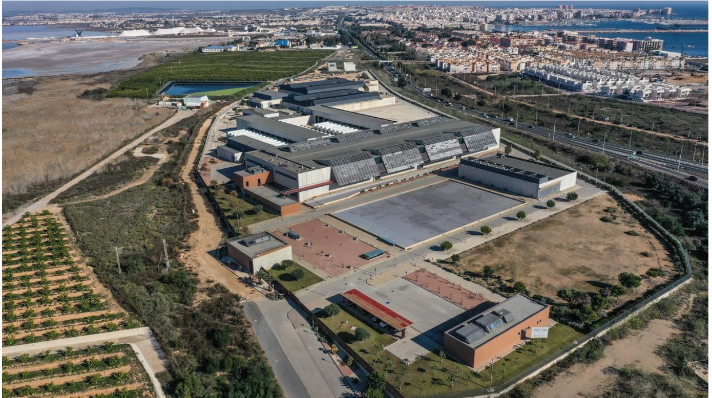
Planta desalinizadora de Torrevieja TONY SEVILLA
