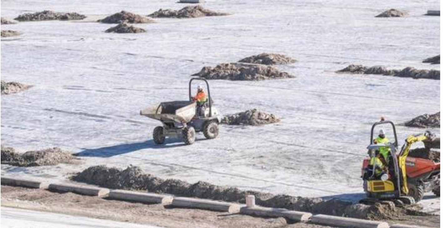
Imagen de trabajos en la balsa del Toscar en Monóvar para que re
