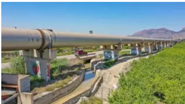
Sifón del postravase Tajo-Segura que conduce el agua al embalse de La Pedrera, atravesando la huerta tradicional de Orihuela / TONY SEVILLA
