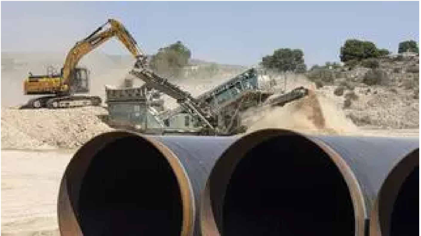
Actuales obras del postravase Júcar-Vinalopó en su margen izquierda / ALEX DOMINGUEZ
