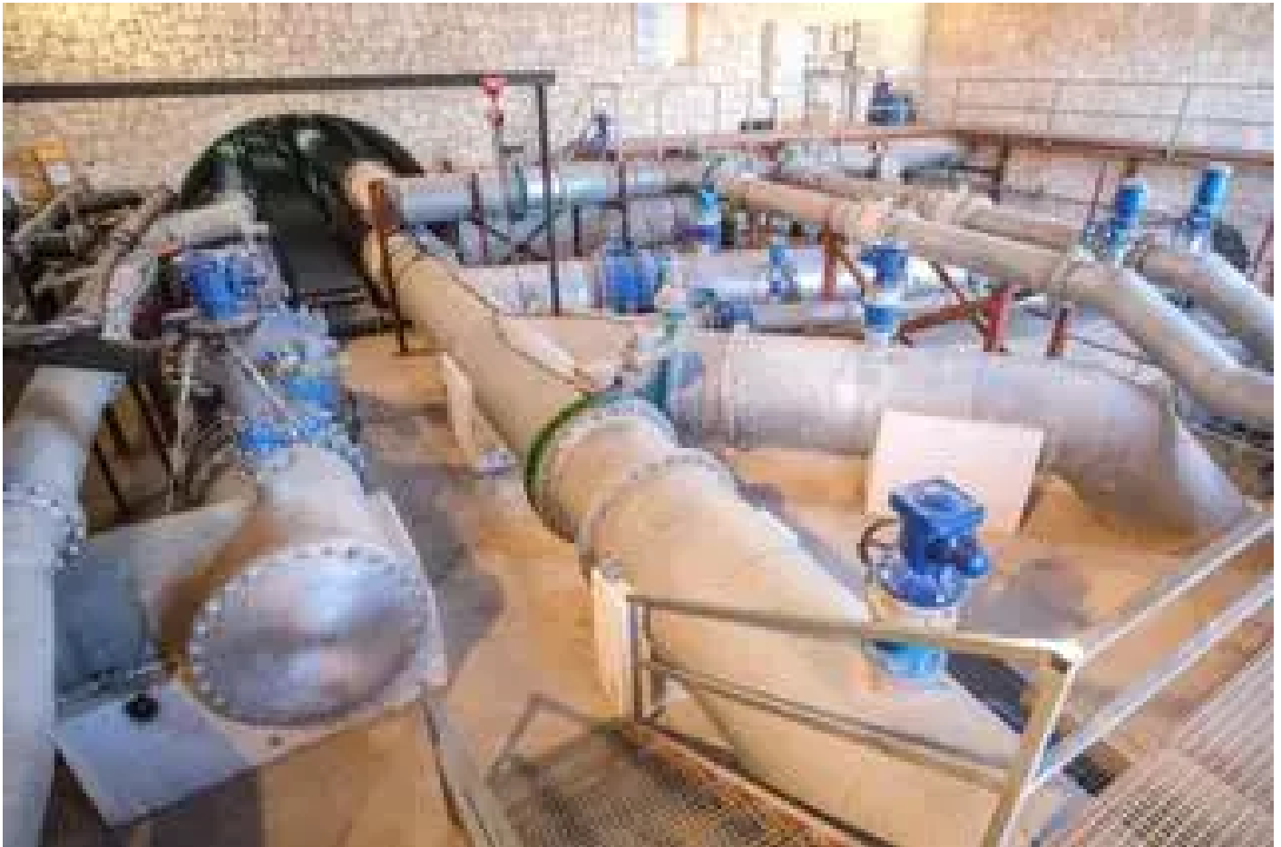
Infraestructuras del postravase del Júcar en el embalse del Toscar / AXEL ALVAREZ
