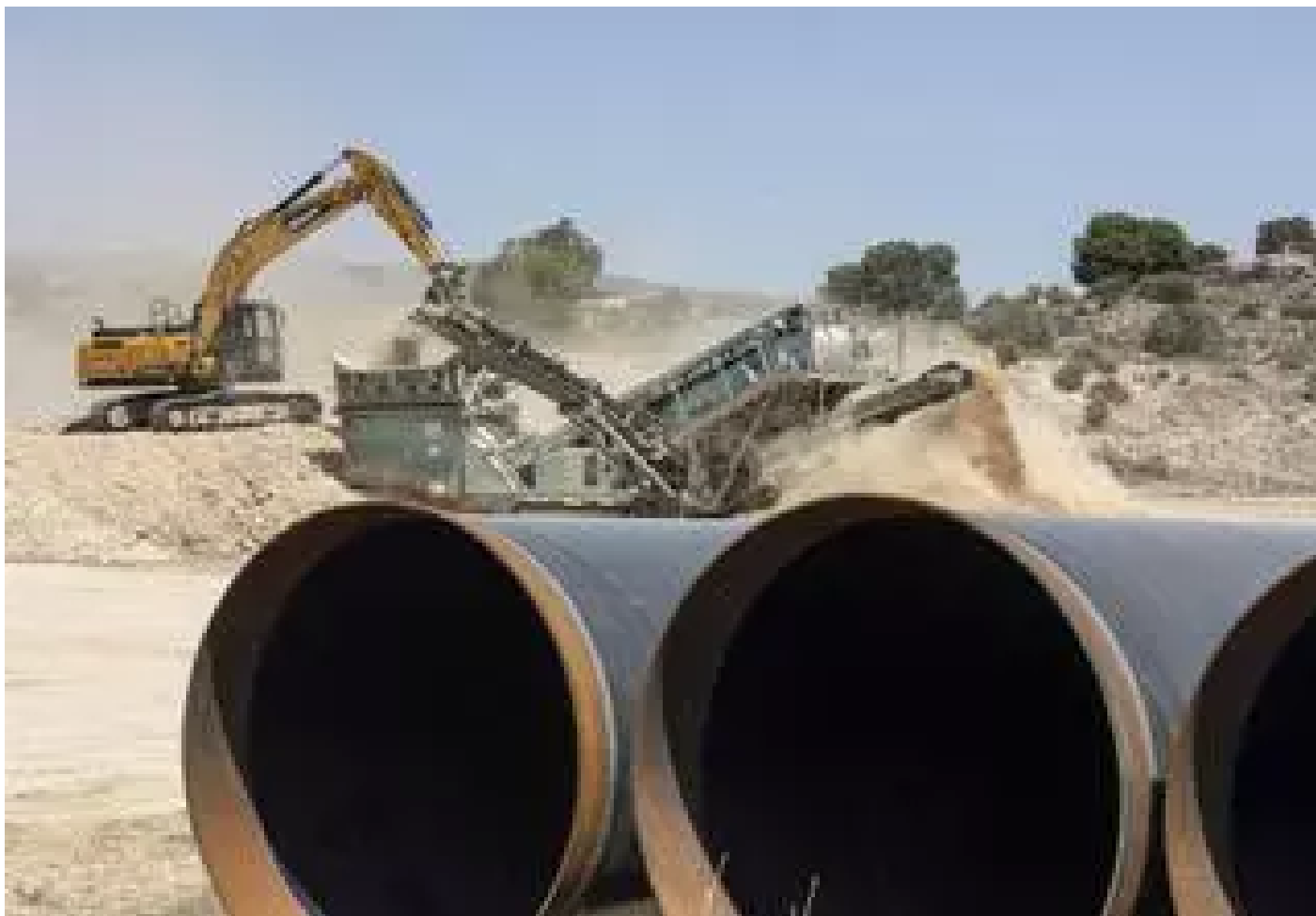
Obras del postravase margen izquierda del Júcar-Vinalopó / ALEX DOMINGUEZ
