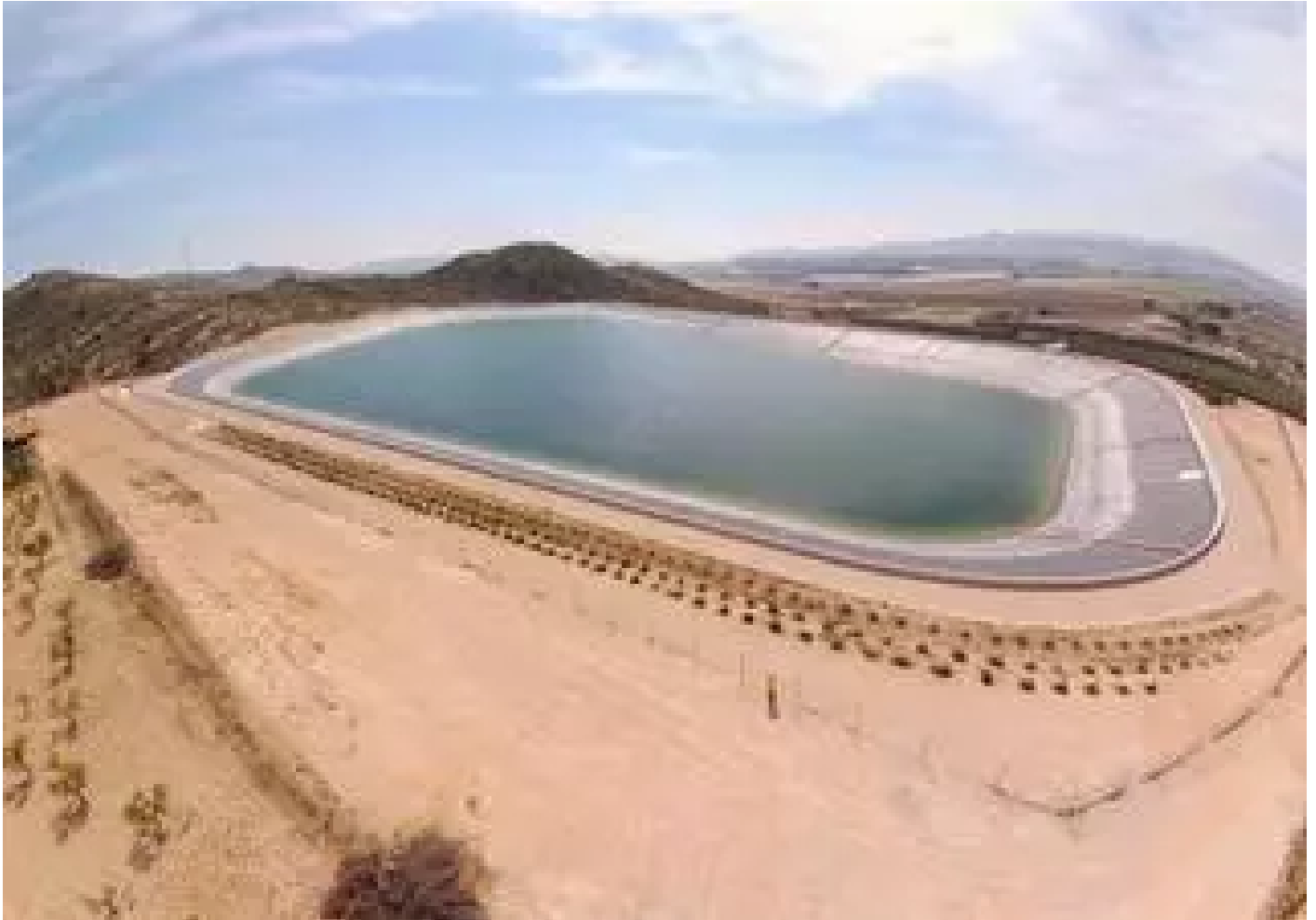
Embalse de La Cuesta, uno de los reservorios de agua del postravase Júcar-Vinalopó / ÁXEL ÁLVAREZ
