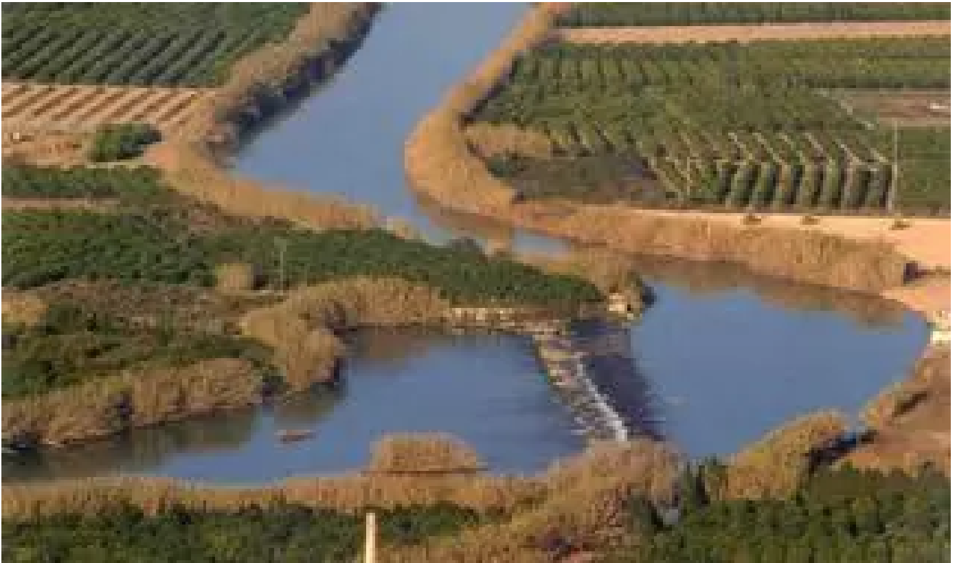
Azud de La Marquesa, en Cullera (Valencia) a pocos kilómetros del mar, desde donde se capta el agua del trasvase al Vinalopó / INFORMACIÓN
