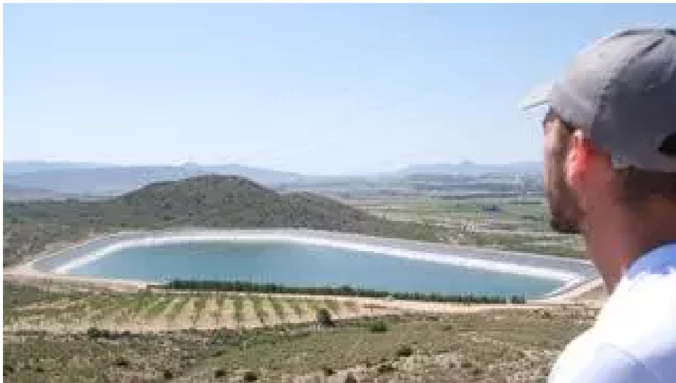
Embalse de La Cuesta, infraestructura del postravase Júcar Vinalopó. / ÁXEL ÁLVAREZ
