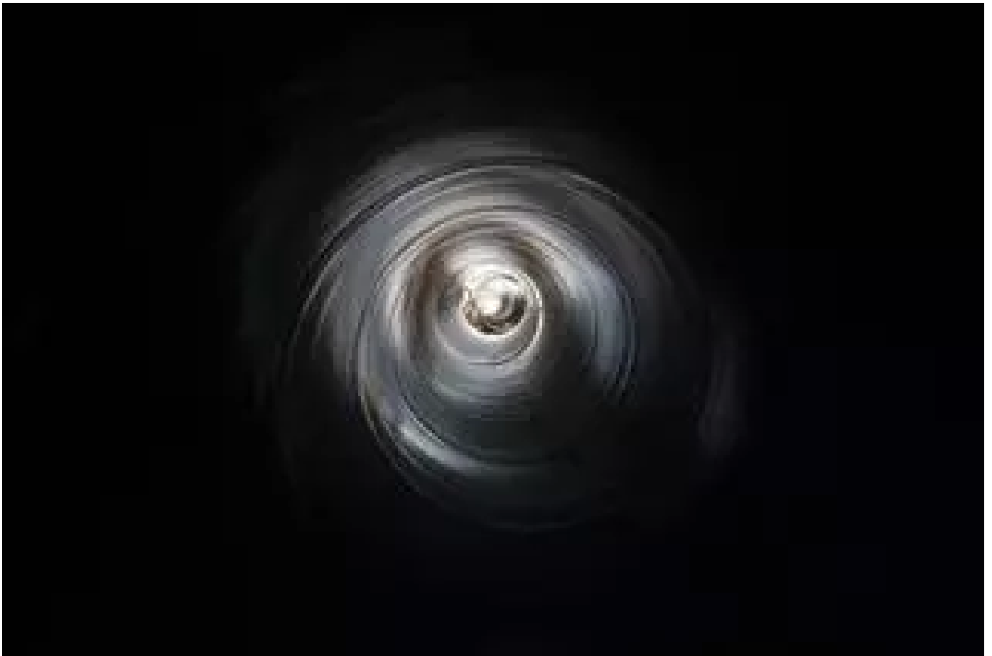
Interior de uno de las secciones de los tubos empleados en el postravase / PILAR CORTÉS
