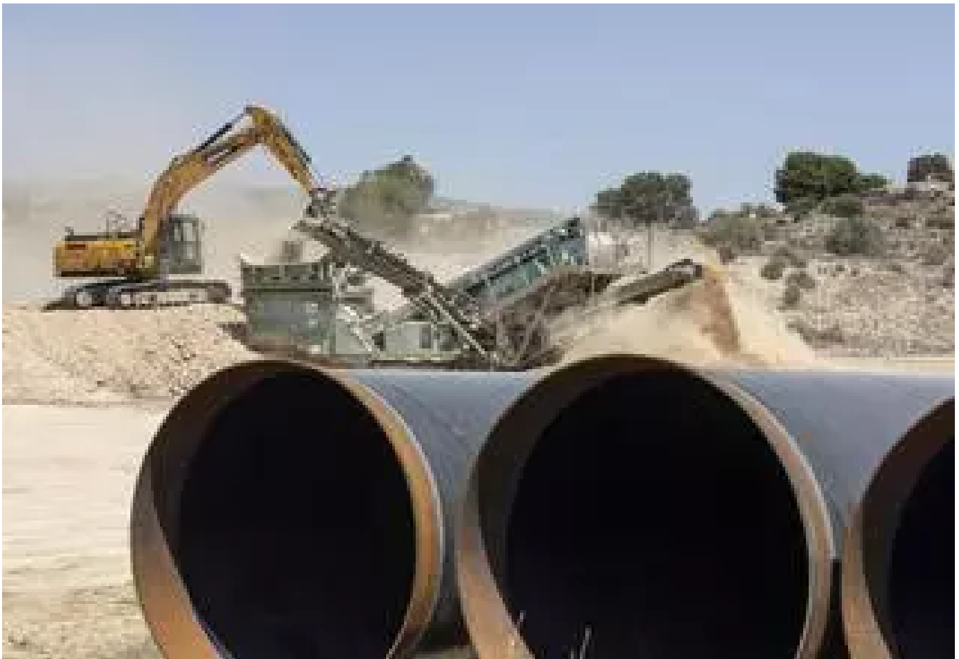
Obras del postravase del Júcar-Vinalopó en las proximidades de Aspe / ÁLEX DOMÍNGUEZ
