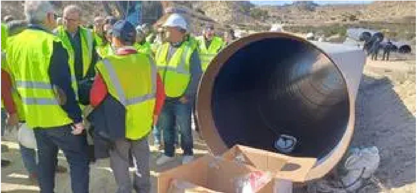
Obras del postrasvase Júcar Vinalopó margen izquierda / D. PAMIES
