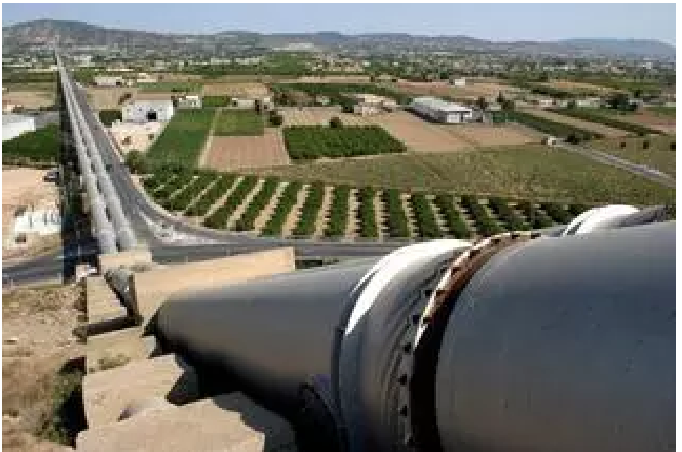
Canalización del trasvase Tajo-Segura, en Alicante / EFE
