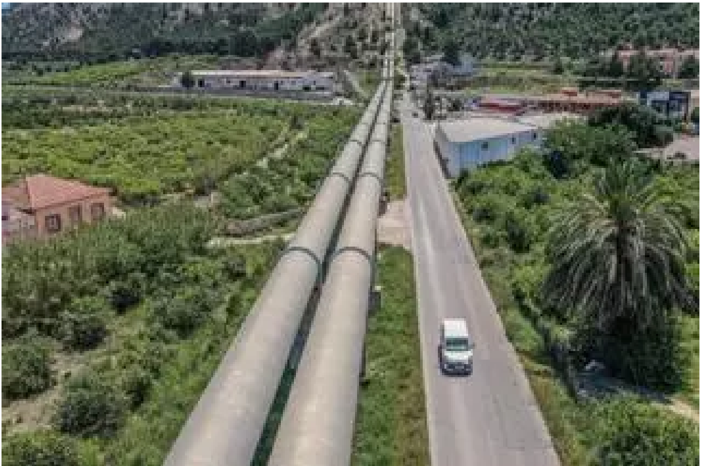
Postrasvase Tajo-Segura en el sifón de la sierra de Orihuela a la Sierra de Hurchillo, atravesando la huerta tradicional / TONY SEVILLA
